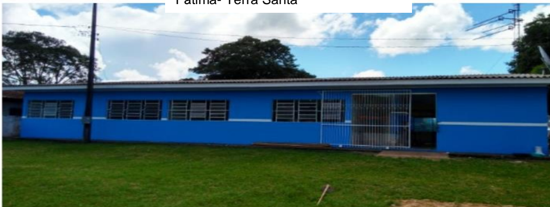
Reformas na Escola Nossa de Fátima- Terra Santa
